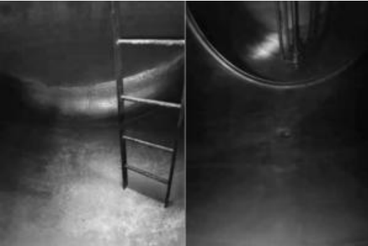
图 3 清洗干净后的储油罐内部
