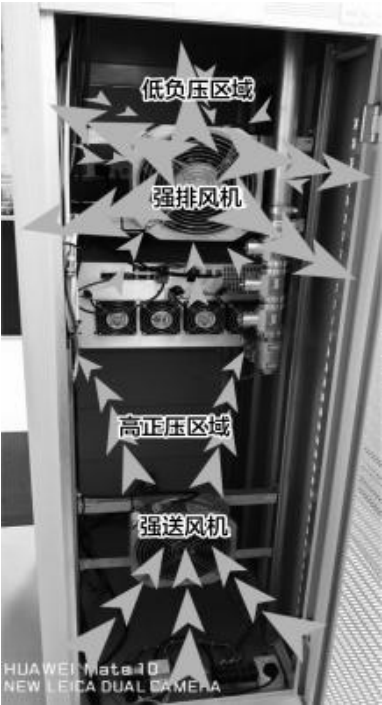
图三 导流散热风机原理及安装
