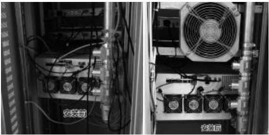
图四 线缆重新规整
